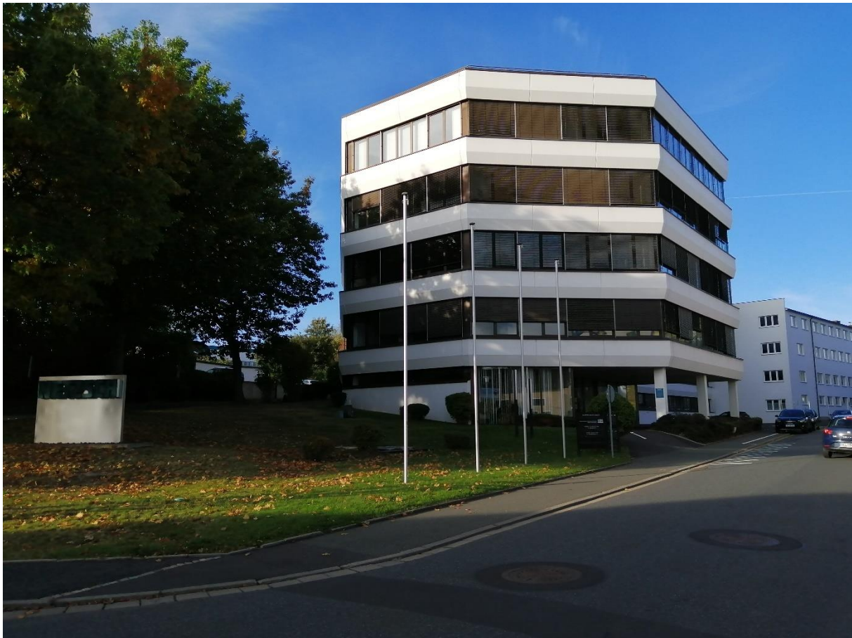
Von 1997 bis 2021 war dieses Gebäude eines Technologieunternehmens Sitz einer Dienststelle der bayerischen Versorgungsverwaltung in Selb (Foto: Eichmeier)
